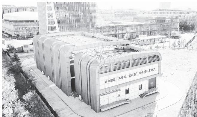
>> 为蓝谷区域国家海洋实验室等“国字号”大项目供电的110千伏蓝谷站 国网青岛市即墨区供电公司 / 供图
