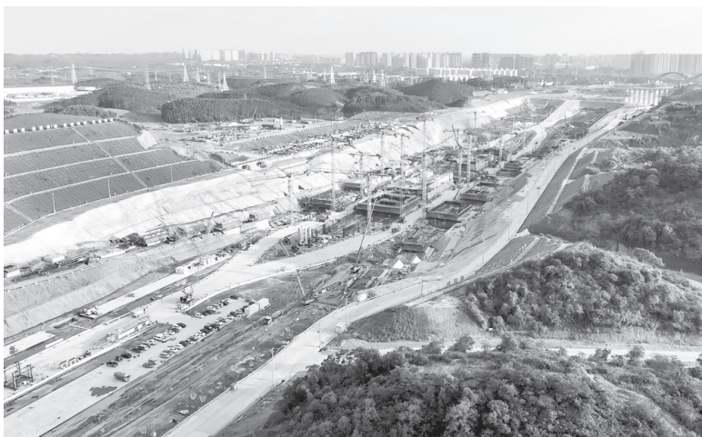
>> 平陆运河工程是新中国成立以来建设的第一条通江达海的运河工程，也是西部陆海新通道的骨干工程，它将助力广西和整个大西南及东盟自由贸易圈迎来全新的腾飞 新华社/发
