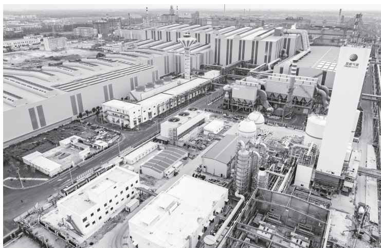
近年来，我国持续打造全球最大的钢铁清洁生产体系，钢铁行业超低排放改造成效显著。图为2024年7月23日，江苏沙钢集团淮钢特钢股份有限公司高炉技改项目（贺敬华/摄）
