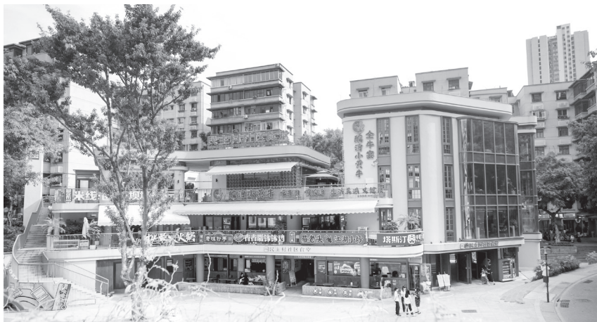
>> 重庆民主村社区是原国企配套家属区，始建于20世纪50年代。经过实施片区城市更新项目，如今的民主村在建筑外观、服务设施、配套功能、运营方式等方面焕然一新 贾天勇 / 摄
