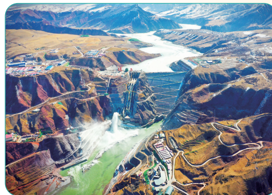
▲玛尔挡水电站全貌（无人机拍摄） 玛尔挡水电站/供图
