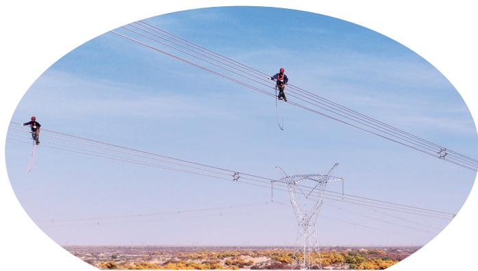
▲在巴州—若羌750千伏输变电工程现场，作业人员正在检查线路 马元/摄
