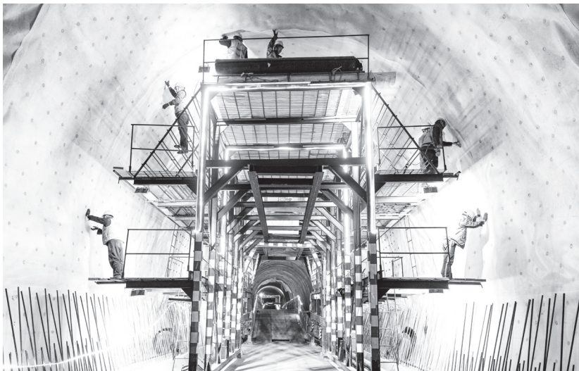
>> 2026年2月13日，在吉尔吉斯斯坦，中国工人在中吉乌铁路贾拉拉巴德隧道施工作业。中吉乌铁路是中吉乌三国元首亲自推动的共建“一带一路”合作的标志性工程，目前已全线开工。 新华社发 任卫云/摄
