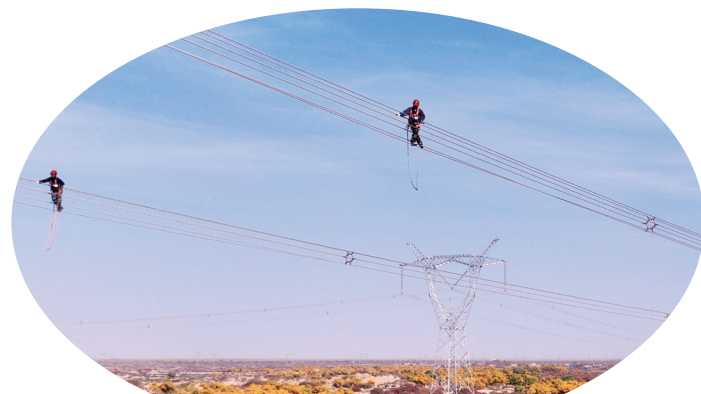
▲在巴州—若羌750千伏输变电工程现场, 作业人员正在检查线路 马元/摄
