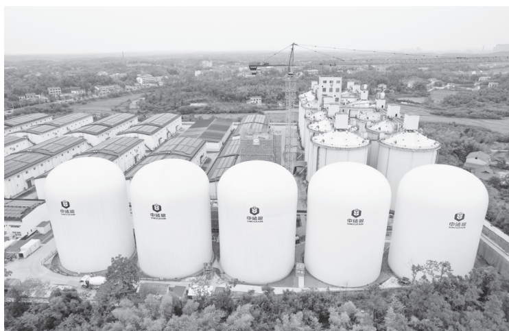
2025 年 5 月 6 日，中国首批 5 座 9000 吨级气膜粮仓在中储粮长沙直属库充气成型，标志着中国第四代新型粮仓进入实践应用阶段。一座仓就可储粮 9000 吨，可以满足 2300 万人一天的口粮需求。图为 5 座充气成型的气膜粮仓（杨华峰 / 摄）
