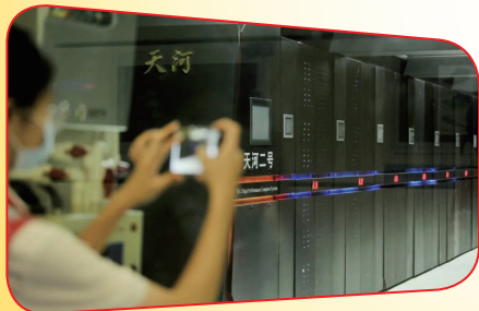
▲参观“天河二号”主机房
